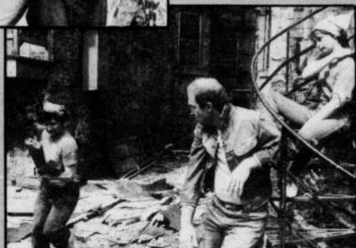
Un fond de cour en démolition devient un décor émouvant dans une dramatique de Radio-Canada, tellement le spectateur n'est pas habitué d'y voir "les vraies choses". (Léonie Scoffé, Charles Vinson et Esther Lewis).
