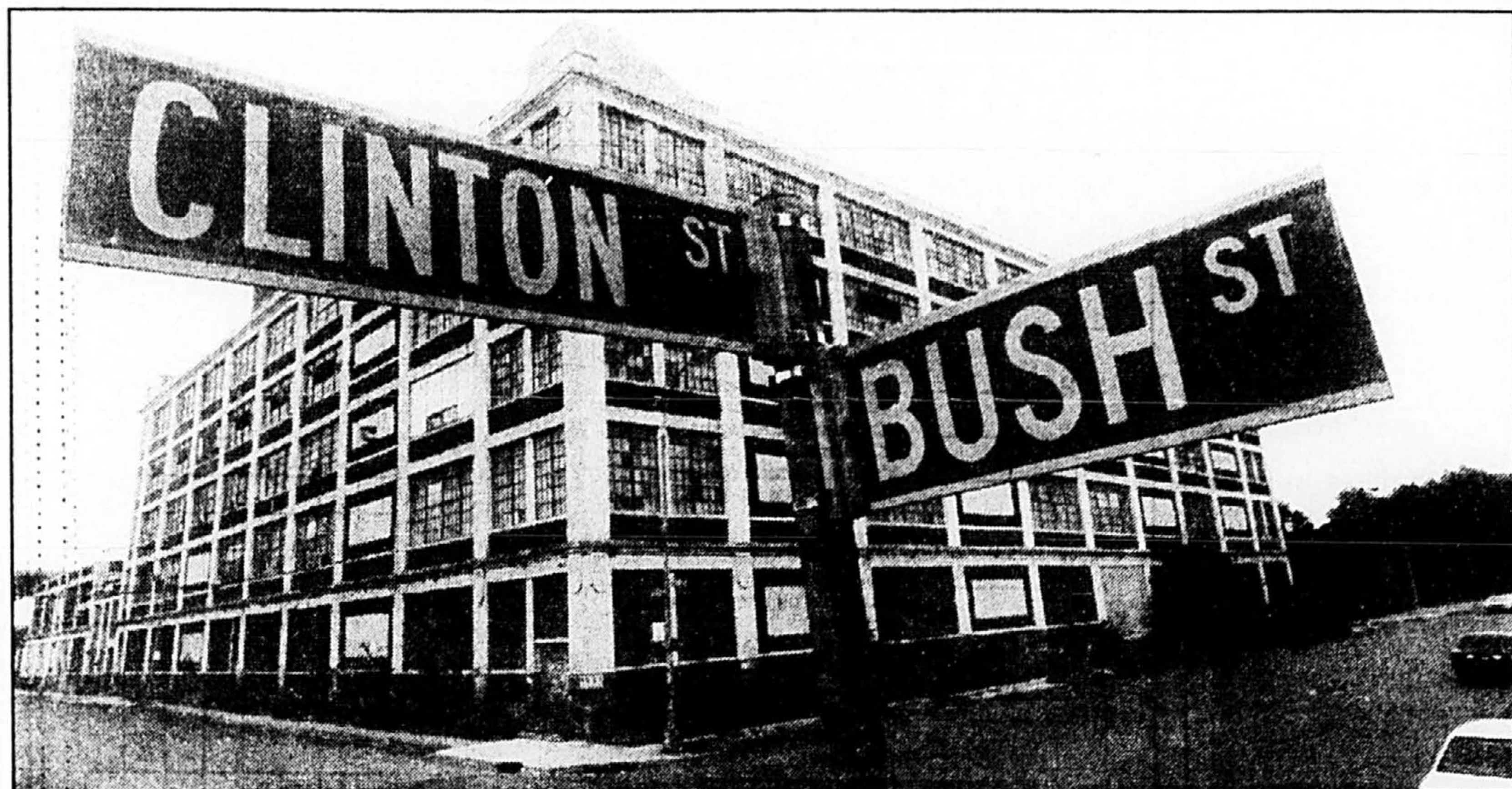
Une fabrique de peinture abandonnée se dresse derrière le panneau indicateur à l'intersection des rues Bush et Clinton à Brooklyn, N.Y. Les préoccupations des résidents de cet endroit isolé sont, d'une part, la hausse de la criminalité et du trafic de drogue et, d'autre part, le manque d'emplois.
