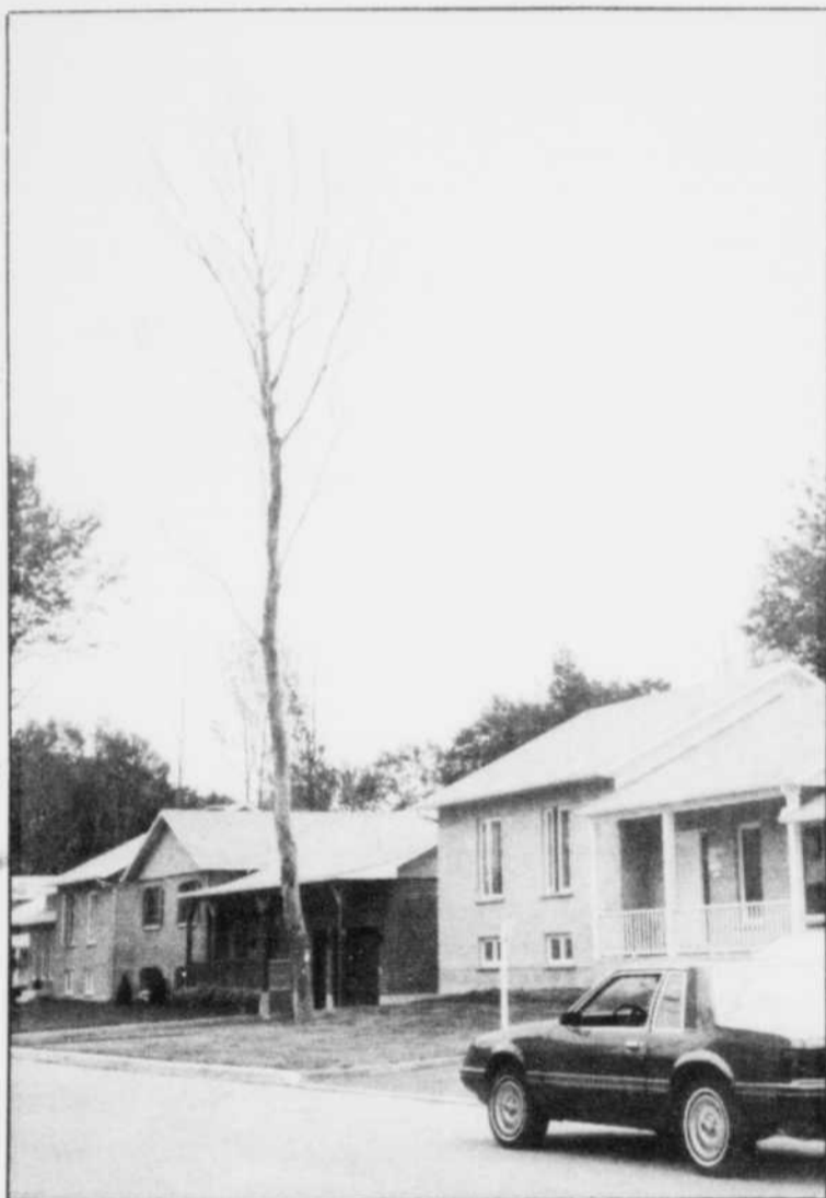
Un exemple de ce qui guette les nouveaux propriétaires. L'arbre n'a pu résister au stress environnemental et présente déjà des dangers.
