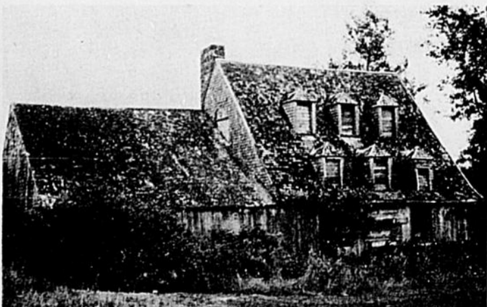
Le Manoir Denechaud: depuis trente ans abandonné et menaçant ruine . . .
