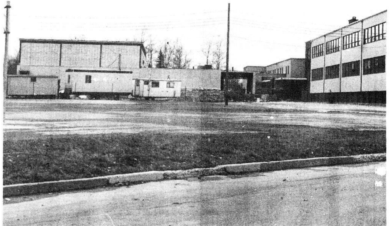
GYMNASE — La Commission scolaire d'Arvida assume la responsabilité d'un investissement de $554,000, consenti pour la construction d'un gymnase sur la rue Hudson.
