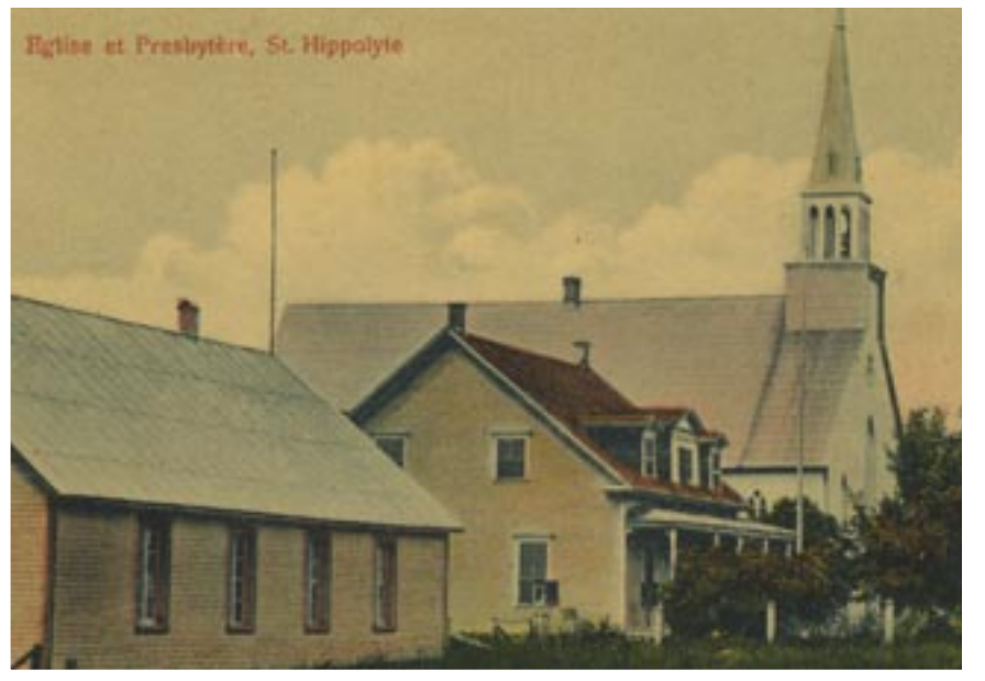
Première église, le presbytère et la salle paroissiale incendiés en 1933
