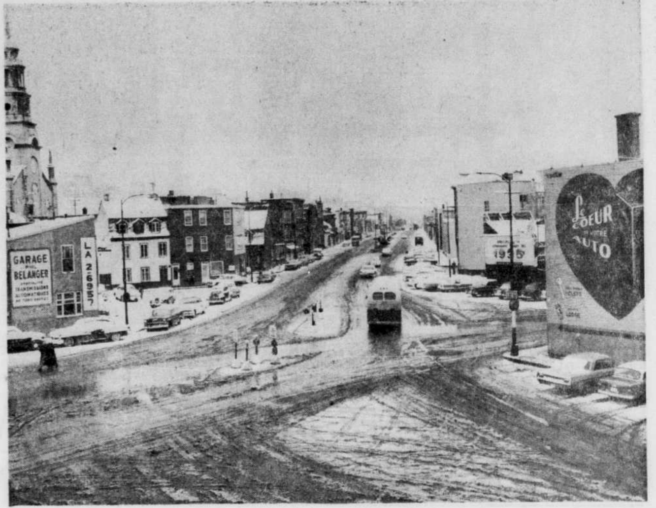
permettre l'asphaltage de cette partie avant l'hiver. L'autre bout, soit de Aqueduc à Marie de l'Incarnation, est passablement avancé. Les services sont en place sur une bonne partie et on complète l'intersection Marie de l'Incarnation pour ouvrir tout le boulevard à la circulation. Le pavage, sur ce dernier tronçon, sera fait au printemps, terminant ainsi des travaux commencés en 1931 pour l'élargissement du boulevard Charest.
