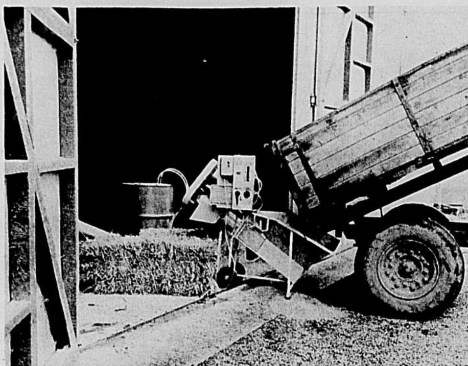
Voici l'un des deux appareils mis au point d'après les données de BP Pétroles Limitée pour le traitement du maïs vert. Tous deux sont équipés d'un moteur électrique de 3/4 c.v. fonctionnant sur courant alternatif de 110 volts et approuvé par le C.S.A. A l'usage, les deux systèmes ont permis d'obtenir un taux de mélange de 99.5%. Le Propcorn est vaporisé sur le maïs au bas de la vis sans fin, au point de turbulence maximale, pour permettre le meilleur mélange possible. (—)
