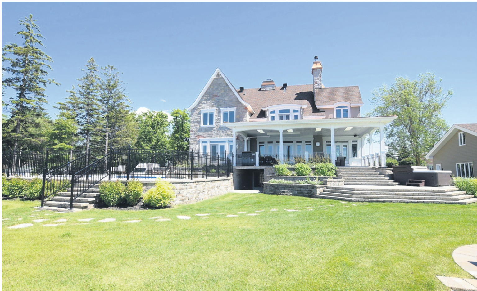
Malgré les apparences qui rappellent les maisons anciennes, la propriété riveraine a été construite en 2008. Voici la façade qui s'ouvre sur le lac. À droite, le second garage détaché.
