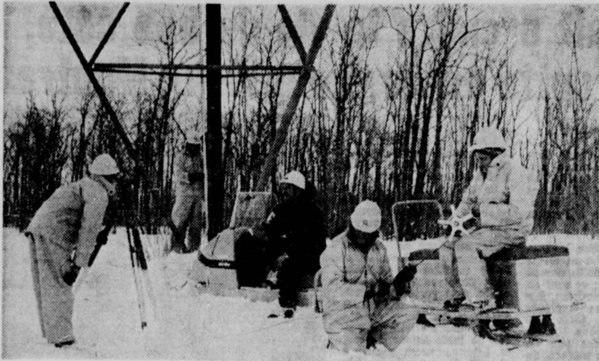
Une équipe d'arpenteurs trace une nouvelle ligne d'électricité. En fond, Michel Fortin, coordinateur à l'Hydro.
