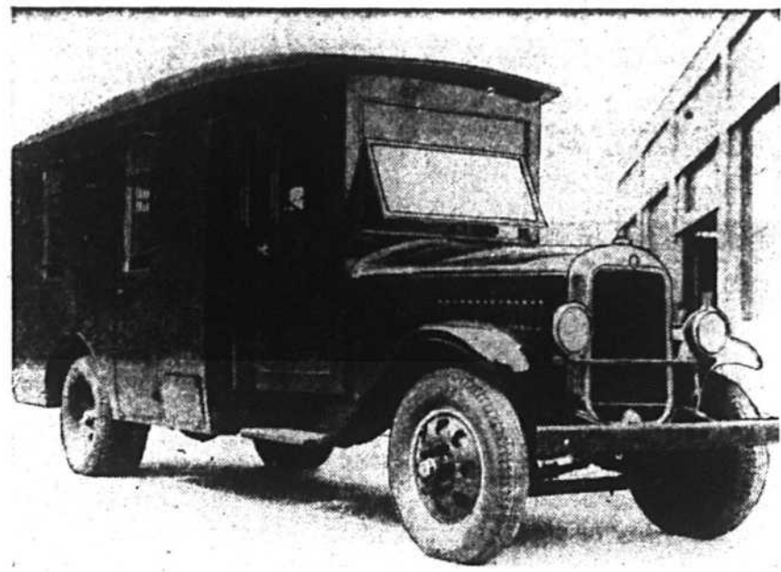
C'est dans ce camion blindé que Montréal distribuait les salaires à ses ouvriers, en 1932, sur les différents chantiers ouverts durant la crise économique. Le camion avait coûté $5,012, y compris un "extra" d'environ $1,000.
