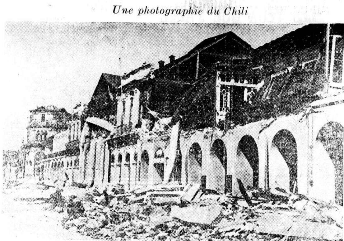
Cette photo montre les débris restant des édifices après le tremblement de terre désastreux qui secoua le Chili et fit plus de 30,000 morts.
