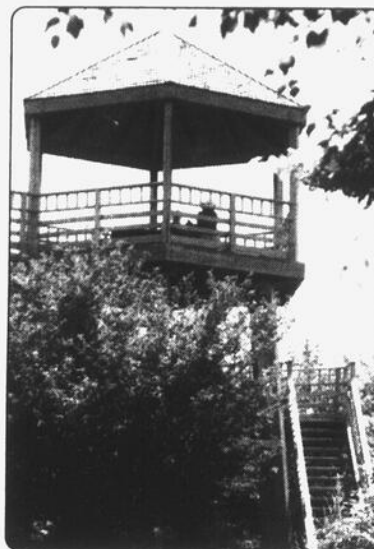
La tour d'observation de la Réserve.
