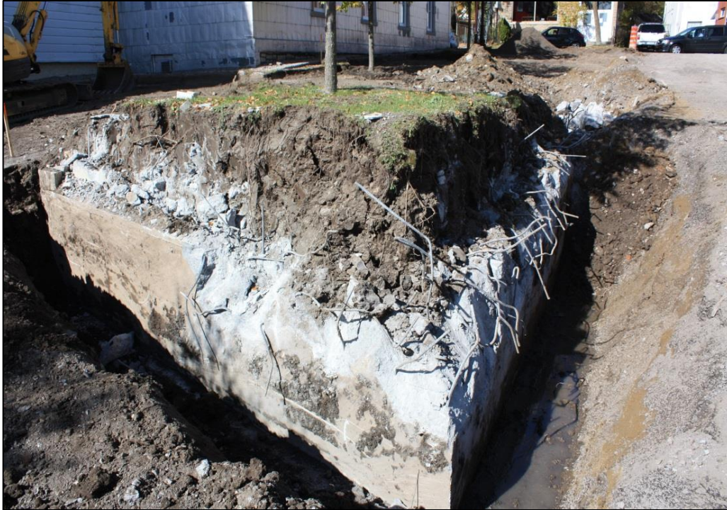
Photo 7. Îlot de béton mis au jour à l'est de l'église Saint-Charles-Borromée, vers l'ouest (CfEt-7-2013-12-014)
