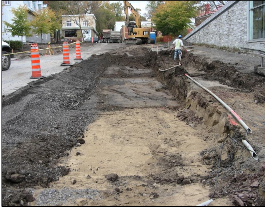
Photo 10. Vue générale de la sous-opération 12B, vers le nord-nord-ouest (CfEt-7-2013-12-058)
