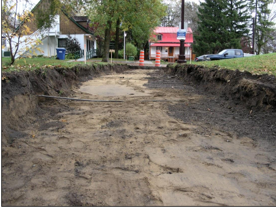
Photo 12. Vue générale de la sous-opération 12C, vers le nord-est (CfEt-7-2013-12-031)
