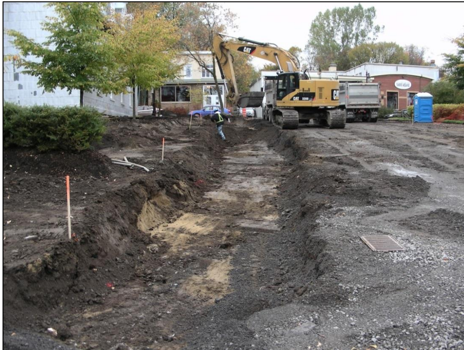
Photo 4. Vue générale de la sous-opération 12A, vers le nord-nord-ouest (CfEt-7-2013-12-040)
