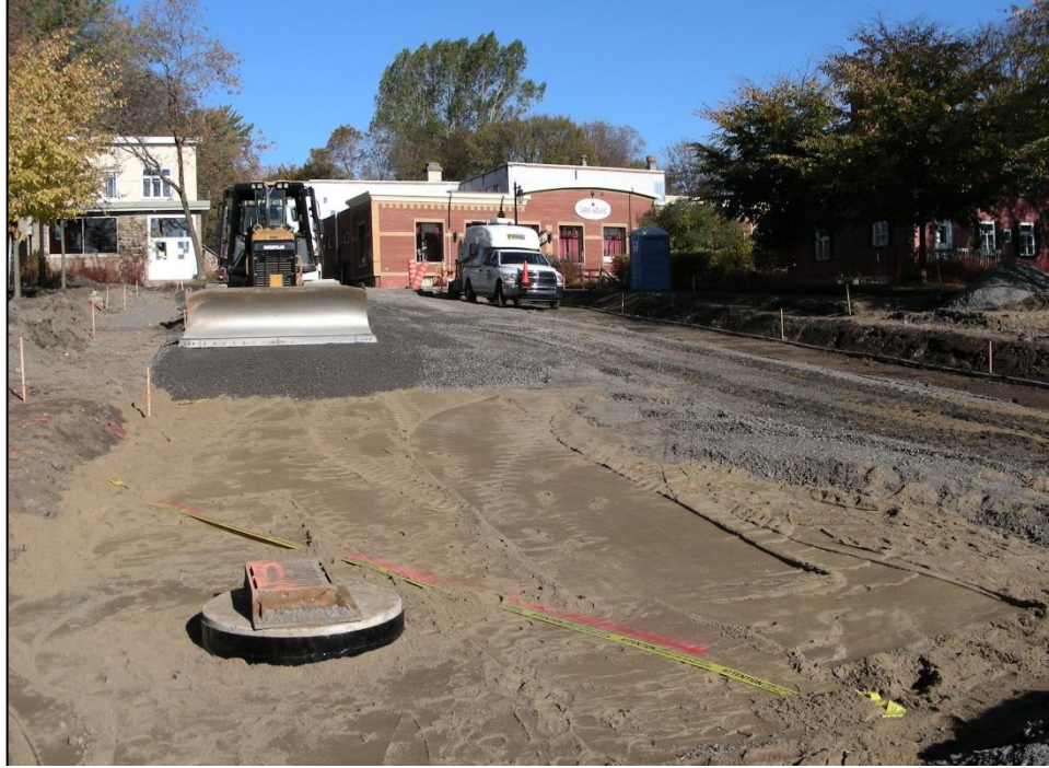
Photo 1. Vue de la zone des travaux située au nord-est de l'église Saint-Charles-Borromée, vers le nord-nord-ouest (CfEt-7-2013-12-096)
