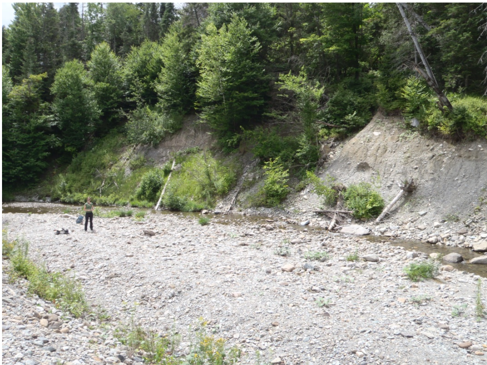
Photo 16 : Rive gauche du ruisseau Gobeil au PK 8,1. Des éboulements se sont produits par endroits dans des dépôts de till localisés sur les rives concaves. Ici, le talus ne semble pas avoir été sollicité depuis un certain temps : les matériaux éboulés ont été délavés de leur fraction fine par les courants, une accumulation de matériaux grossiers s'est formée sur la berge et la végétation se réimplante au pied du talus.
