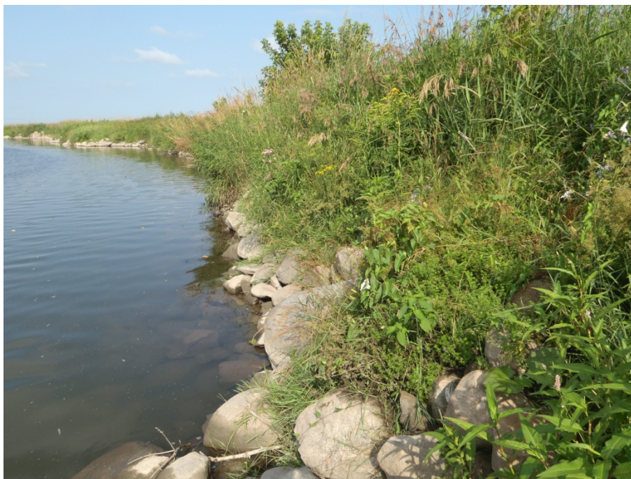
Photo 10 : Rive droite de la Bulstrode au PK 19,3. Reprise de la végétation dans un segment de rive concave où des matériaux de protection ont été mis en place au cours des dernières années.
