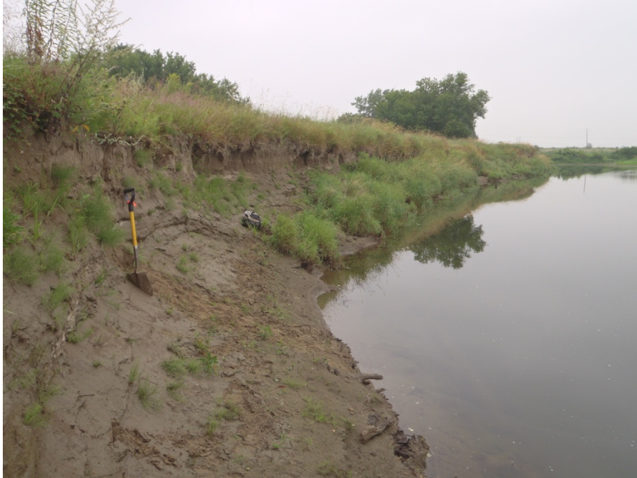
Photo 8 : Rive gauche de la Bulstrode au PK 13,3. Dans ce segment de rivière, les rives concaves érodées sont en grande partie dénudées, mais par endroits la couche végétale éboulée recouvre le pied des talus.
