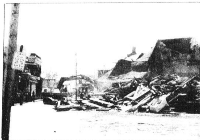
La vieille maison qui devait être la proie des flammes il y a quelques jours, devait finalement être démolie par une grue mécanique qu'on voyait à l'oeuvre jeudi le 11 mai dernier, à Berthierville.
