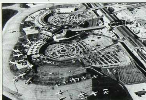
Aéroport de Lyon-Satolas - vue générale
