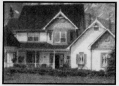
Si elle est bien isolée, votre maison a peut-être besoin d'un échangeur d'air. Photo Isolation Beauport
