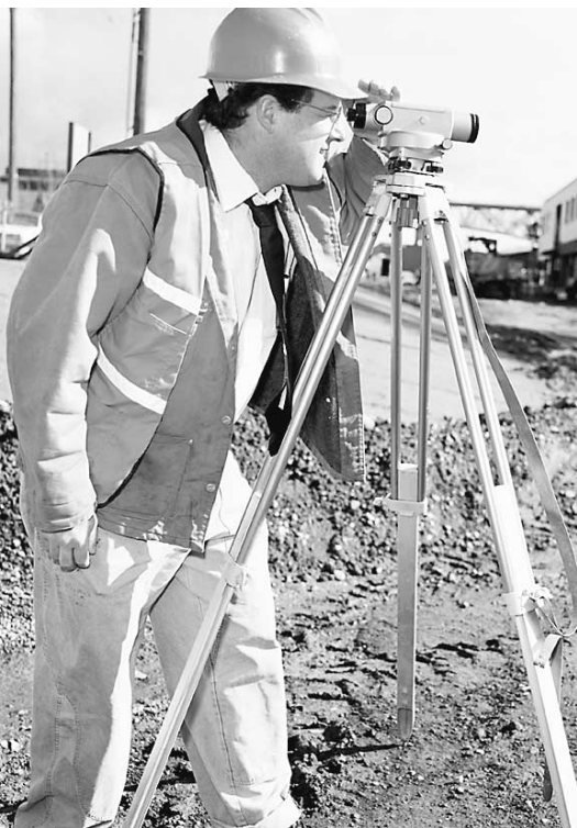
La poursuite du déficit zéro avait mis un frein à la construction et à la réfection des infrastructures. On sent maintenant un regain d'activité.
