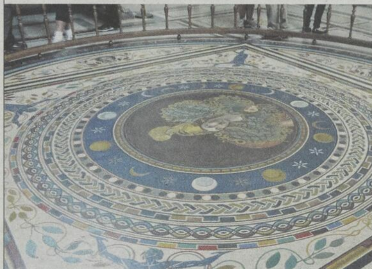
Fine mosaïque d'une section de plancher bien délimitée et interdite à la circulation.
