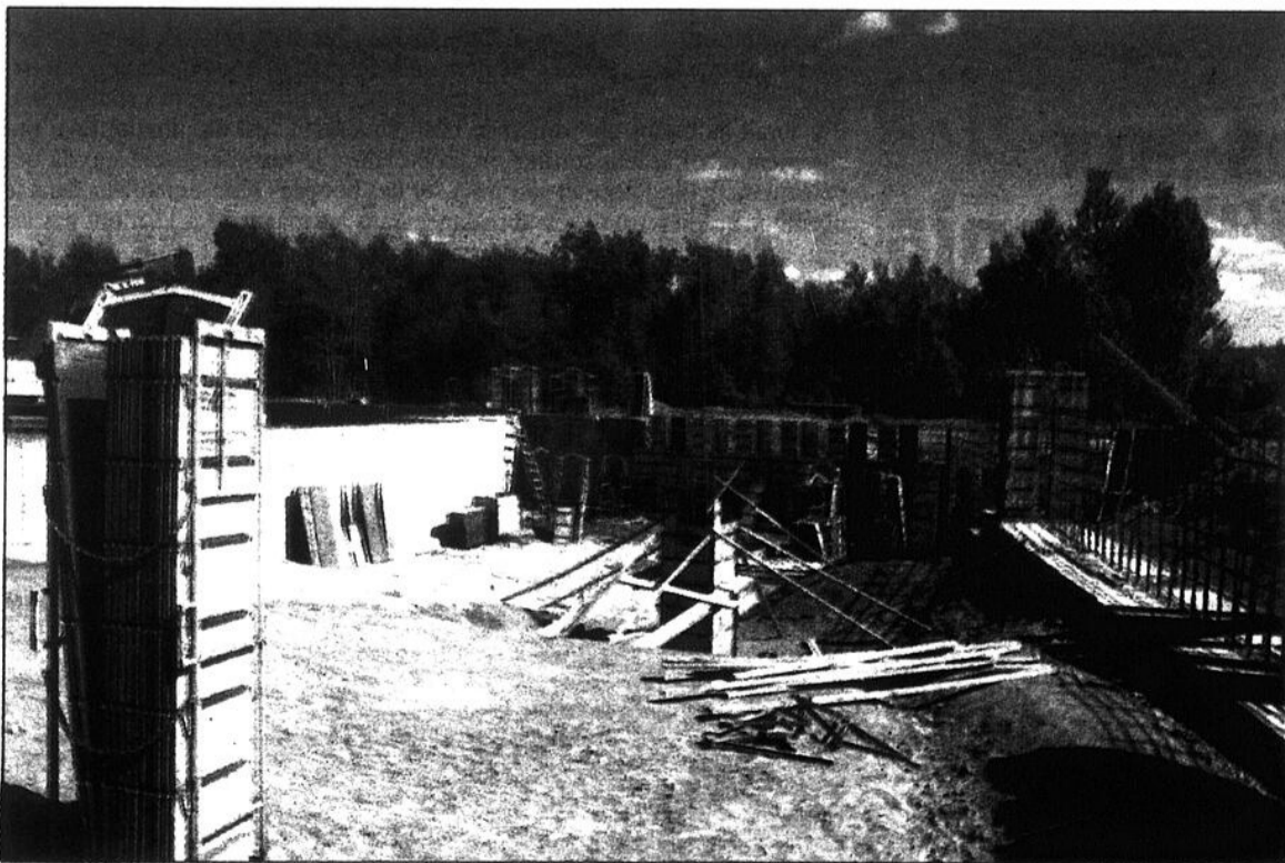
L'emplacement de la future piscine, en date du 24 août.
