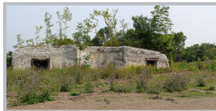
➤ Les vestiges d'une des deux casemates qui risquent d'être démolies sur le site du Domaine Saint-Laurent.
