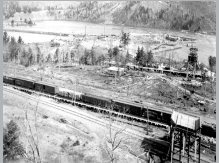
Cette photo nous montre la déviation des eaux pour permettre la première section des préparatifs à la construction du barrage La Gabelle.
