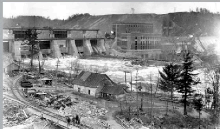
Vue d'ensemble du chantier. Des passes temporaires avaient été installées sous l'évacuateur en construction. On aperçoit aussi la maison du draveur qui est demeurée longtemps en place suite à la fin de la construction du barrage et de la centrale hydroélectrique.
