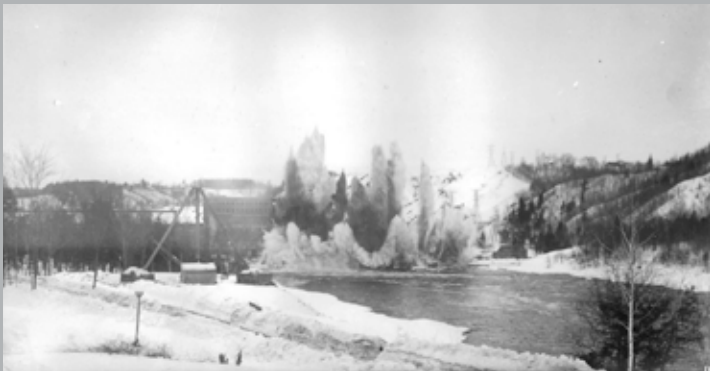
En février 1924, on a fait exploser les batardeaux (Un batardeau est un barrage destiné à la retenue d'eau provisoire en un lieu donné sur une surface donnée) à l'amont du site afin de procéder au nettoyage de la rivière avant la mise en marche de la centrale hydroélectrique.
