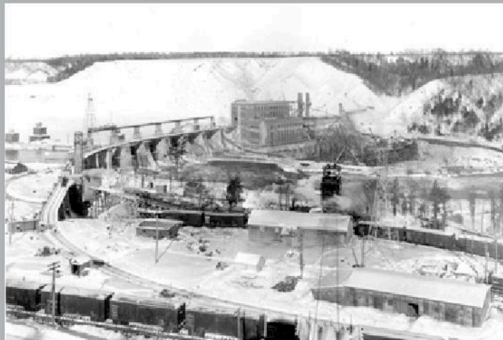
Une vue de l'ensemble du projet pendant l'hiver 1923-1924; probablement pour représenter les derniers travaux de la centrale hydroélectrique. En tout petit, au centre, on peut apercevoir la maison du draveur.
