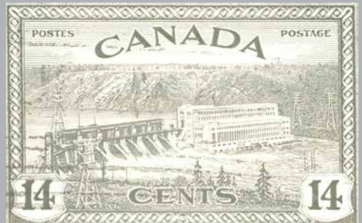
Vu l'importance et la qualité de construction, Poste Canada a émis un timbre en hommage au barrage La Gabelle.
