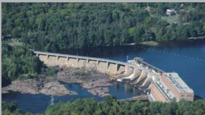
Vue du barrage en période estivale, le 3 septembre 2014.
