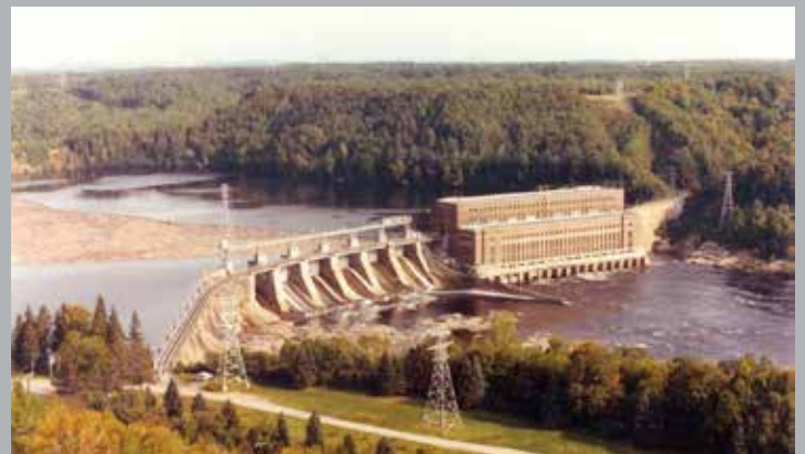
Vue du barrage dans les années 197x.
