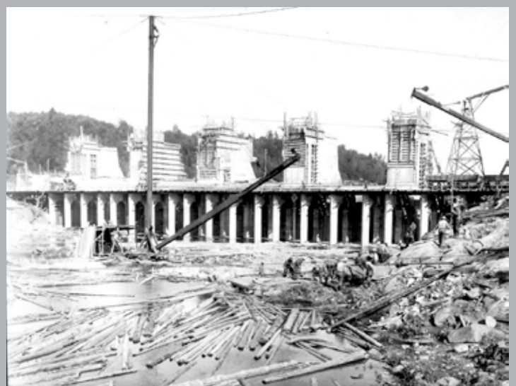
Photo nous montrant une partie du modèle de grues utilisées pour la construction.
