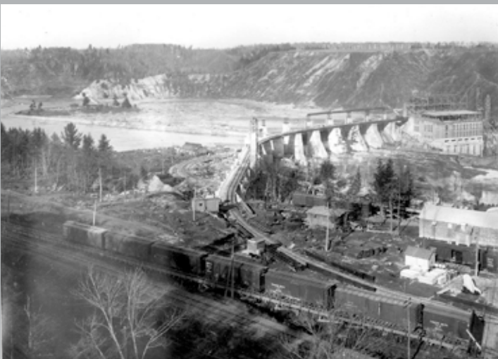
L'évacuateur vu de la rive droite, été 1923. Un nouveau chenal a été excavé et l'eau s'écoule maintenant sous les passes de l'évacuateur; le lit de la rivière commence à s'assécher. Une voie ferrée a été installée sur le tablier.
