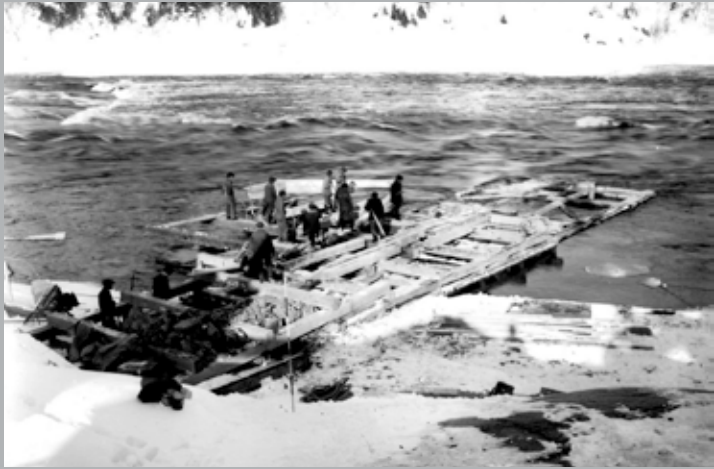
La mise en place d'un batardeau durant l'hiver 1922-1923. L'installation du chantier avait débuté à la fin de l'automne 1922. Un batardeau est un barrage destiné à la retenue d'eau provisoire en un lieu donné sur une surface donnée.
