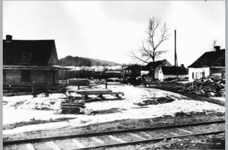
Vue partielle du campement. Jusqu'à 2 000 hommes travaillèrent en même temps à la construction de la Gabelle.
