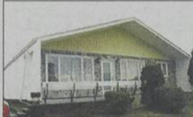
CHICOUTIMI: 413, St-Gabriel. Maison ayant subi plusieurs rénovations, 4 chambres, armoires de bois, piscine creusée. *Lise Côté: 418-820-1741
