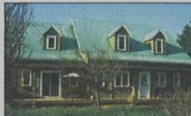
ST-FULGENCE: 4, rang St-Joseph. Construction exceptionnelle, tout bois int. et ext., 3 ch. *Hélène Turgeon: 418-590-1818
