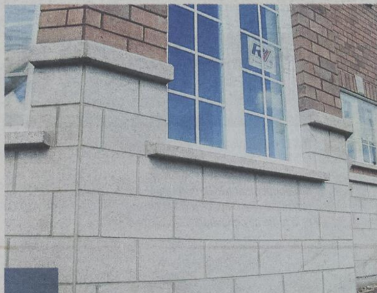
LEED - Sur l'échelle de pointage LEED, les blocs architecturaux Alba peuvent atteindre de 7 à 17 points.
