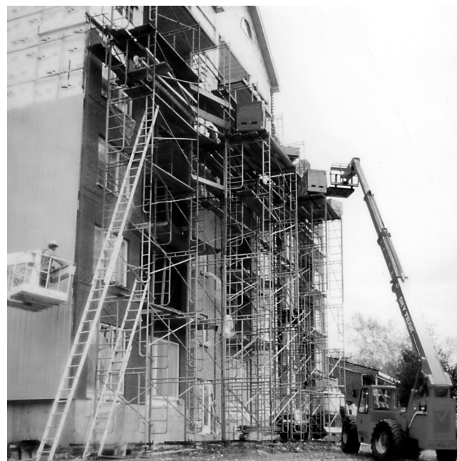
Échafaudage sur cadres métalliques ouverts
