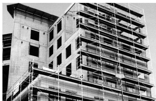
Échafaudage sur cadres métalliques européens
