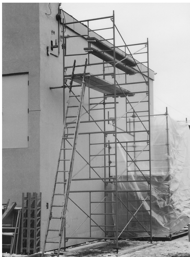
Échafaudage sur cadres métalliques traditionnels
