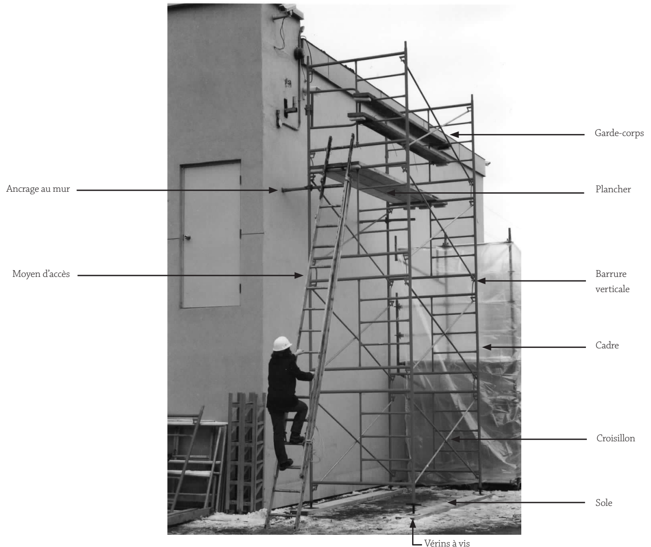
Composants des échafaudages sur cadres métalliques
