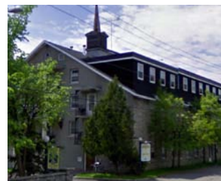
Le bâtiment actuel
