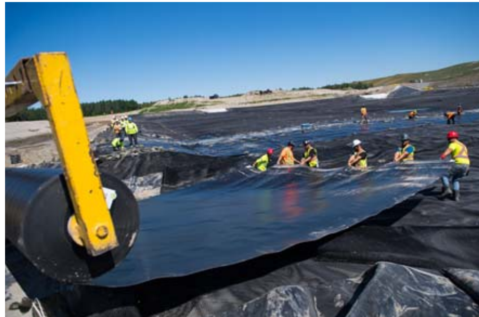
Des employés s'affairent à l'aménagement d'une cellule d'enfouissement à l'aide de plusieurs couches de membranes étanches.
