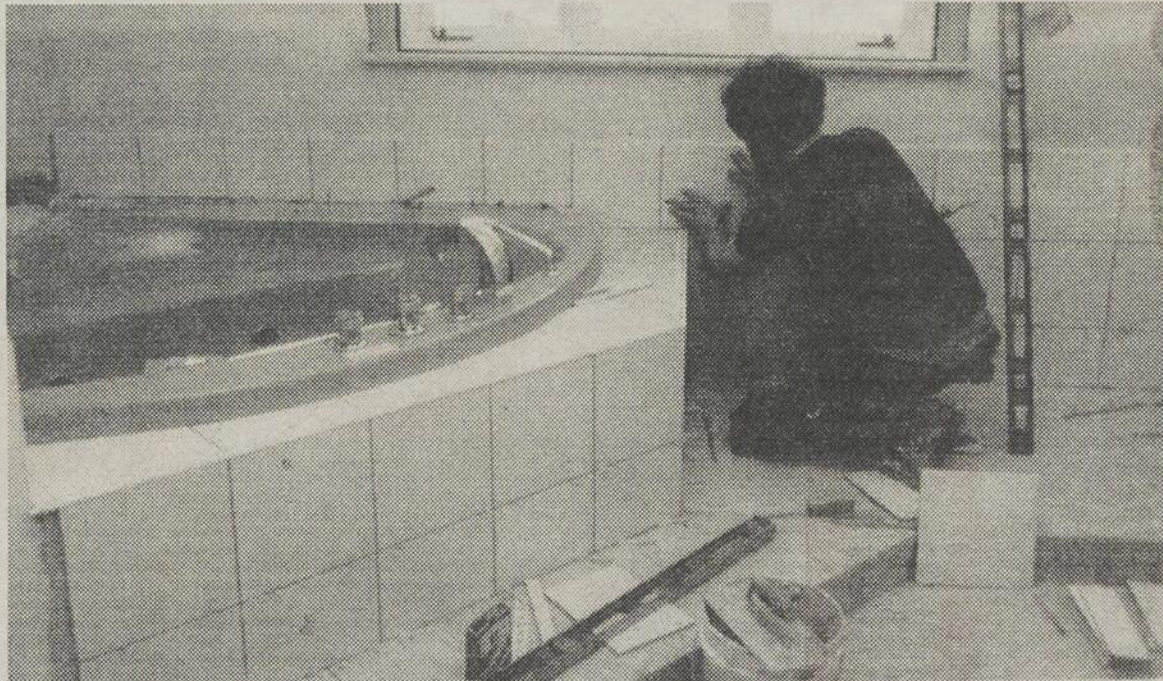
TRAVAUX - Il est important de dresser une liste complète des travaux à réaliser afin de bien informer votre entrepreneur.
