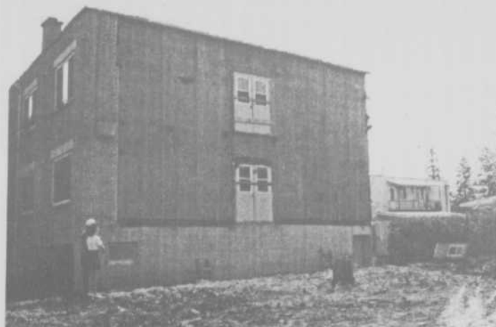
Après une dizaine d'années d'attente, les travaux d'agrandissement et de rénovations du Centre d'hébergement St-François, qui s'élèveront à 600 000$, ont finalement débuté le 27 mai. Un ascenseur, une salle communautaire, des salles de bain thérapeutiques et un jardin extérieur viendront notamment combler des besoins criants. (Photo: Joël Goulet)
