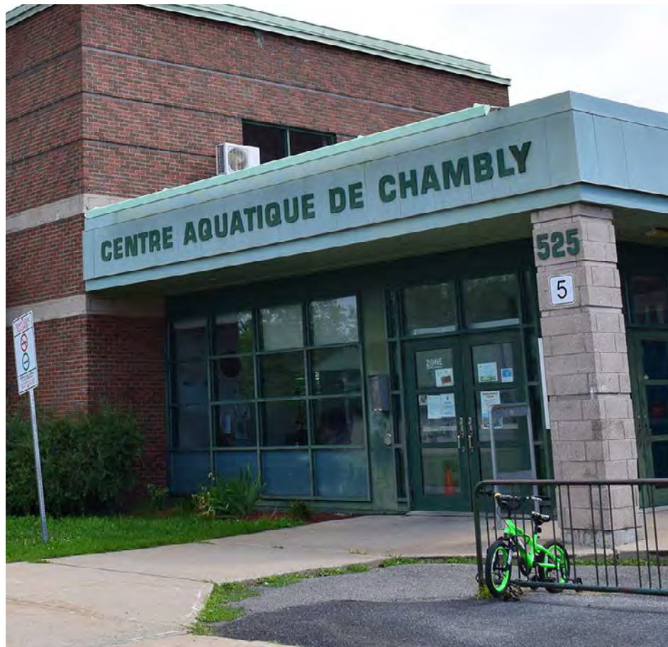
La Ville profitera des travaux de plomberie effectués pour installer le matériel nécessaire en prévision de l'ajout d'un système de traitement UV. (Photo : archives)
