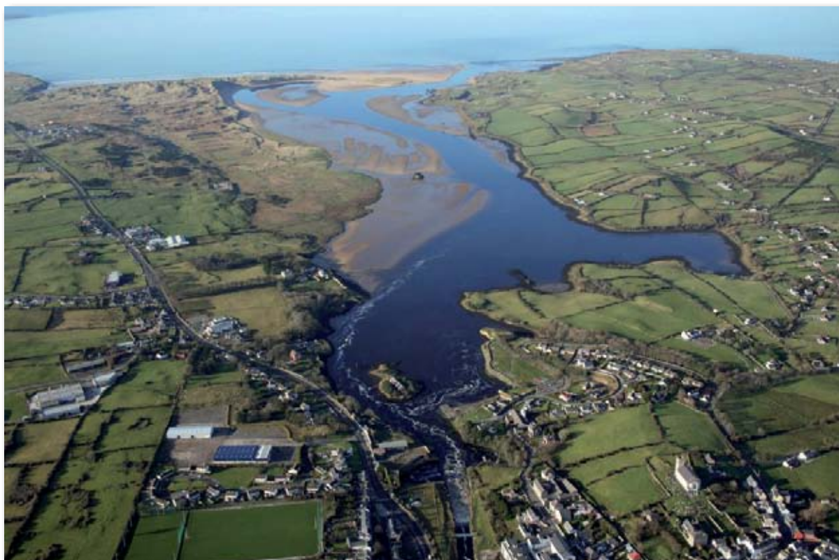
Vue aérienne de Ballyshannon
