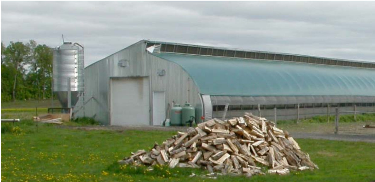
Bâtiment d'origine ayant subi des modifications
