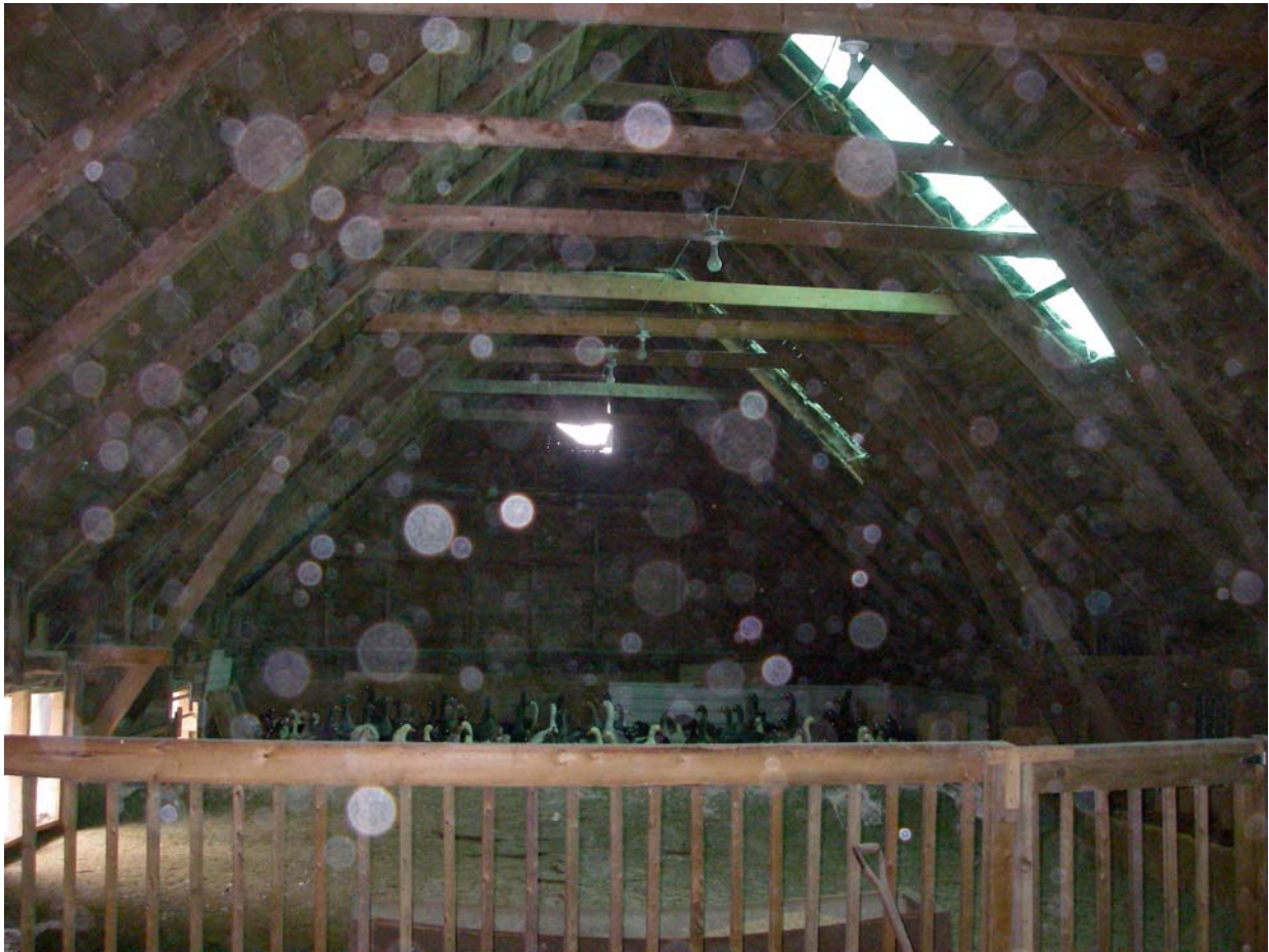
Intérieur du bâtiment
