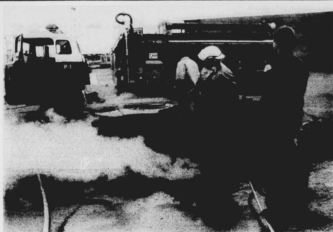
EPAISSE FUMÉE — Lorsque les pompiers sont arrivés sur les lieux de l'incendie, une épaisse fumée sortait des puisards donnant accès aux conduits électriques souterrains. (Photo Real Tremblay)
