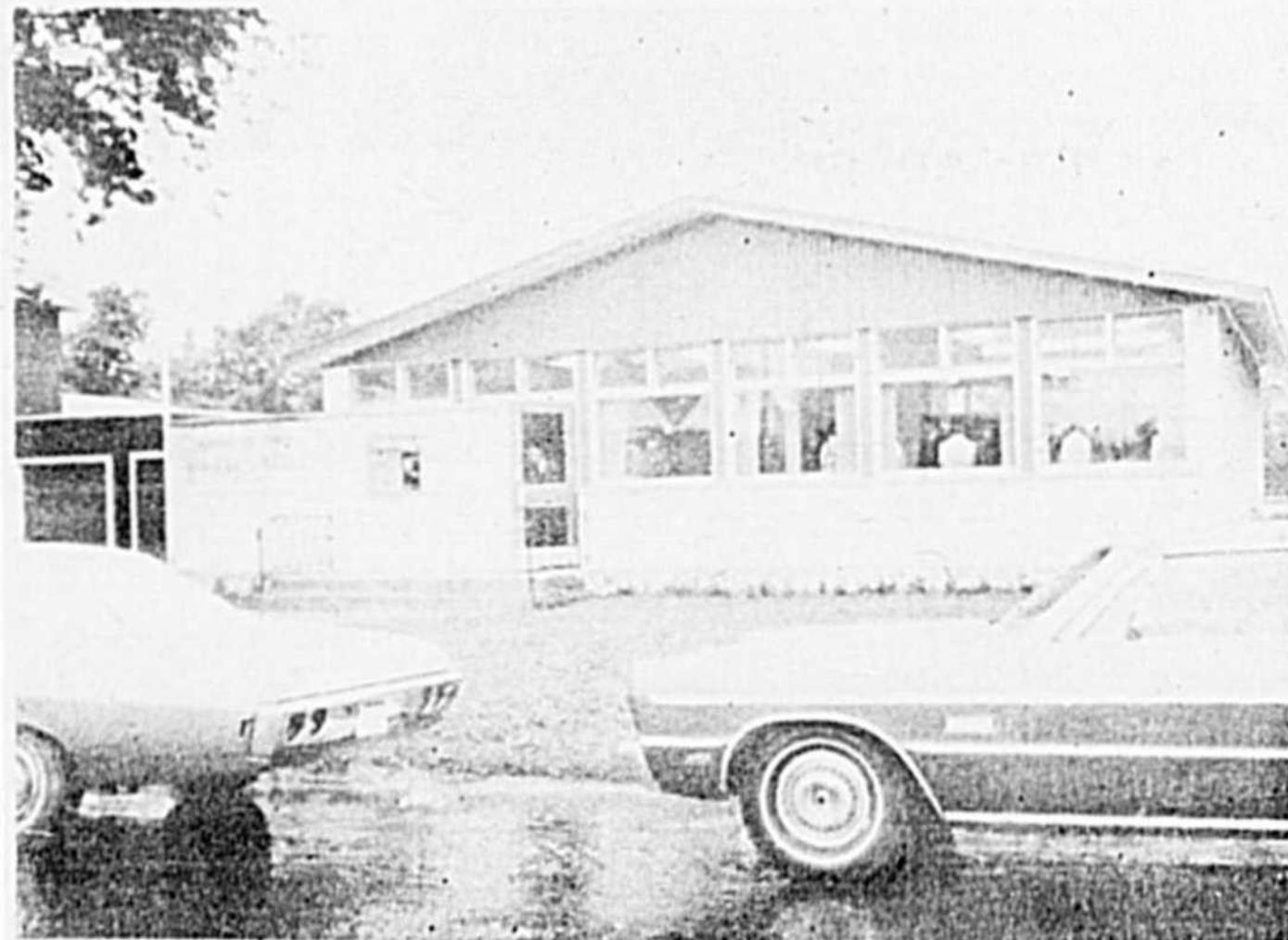
Vue extérieure du Bureau de Poste construit par Bruno Laroche, entrepreneur de Warwick. Cet édifice est la propriété de M. Maurice Raiche de Kingsey-Falls.
