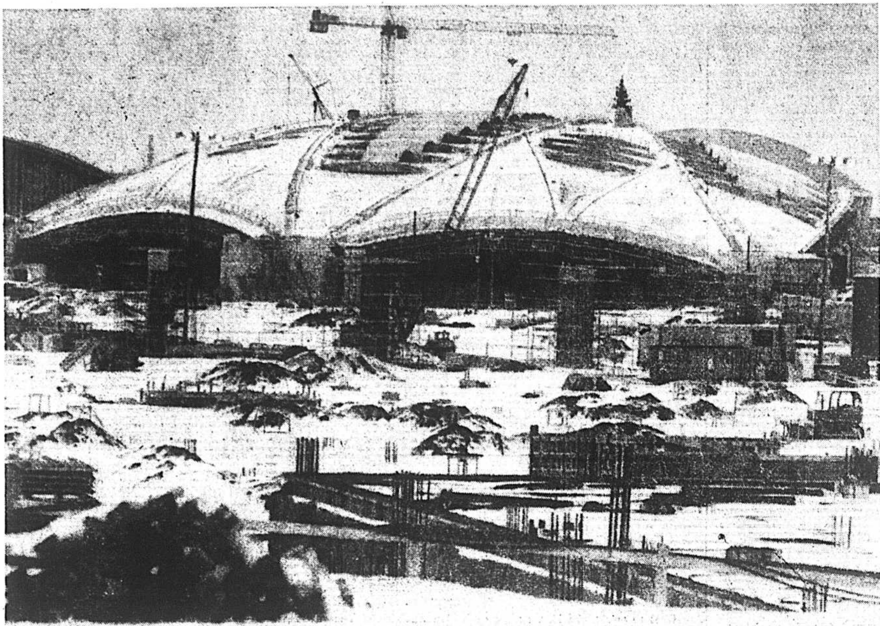
Les travaux ont repris ce matin sur les principaux chantiers des Jeux olympiques d'été de 1976. Les travaux étaient paralysés depuis six semaines par la grève des ferrailleurs. Ces derniers ont accepté la semaine dernière l'offre que leur a faite le gouvernement provincial pour ajuster leurs salaires à l'augmentation du coût de la vie.
