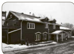
32 GARDNER, WINDSOR GRAND GARAGE DOUBLE AVEC LOYER AU 2E.
