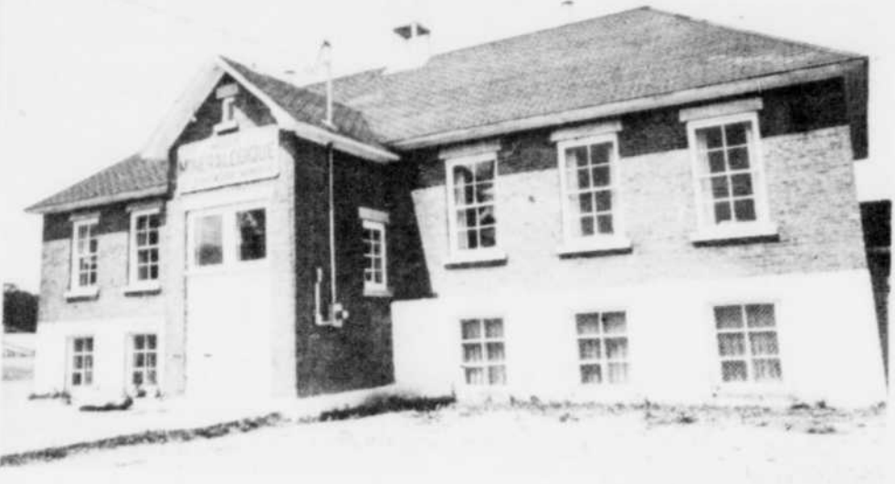
Malgré certaines difficultés, le Musée minéralogique d'histoire minière d'Asbestos, a été rouvert au public pour un troisième été.
