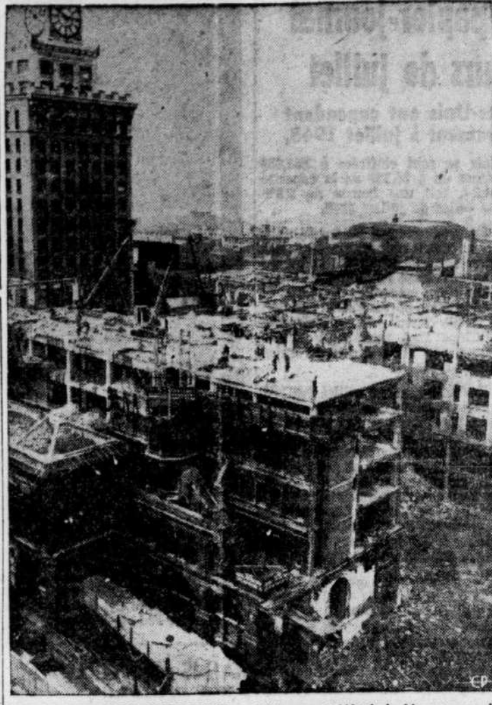
UN GRATTE-CIEL DISPARAIT — L'imposant Hôtel de Vancouver disparaît sous les coups de pioches des démolisseurs. Ce gratte-ciel qui faisait l'orgueil de cette ville de la côte du Pacifique changera totalement d'aspect puisqu'il sera remplacé par un grand magasin à rayons de la compagnie T. Eaton. L'on espère compléter les travaux de démolition vers la mi-octobre. (Photo C.P.)
