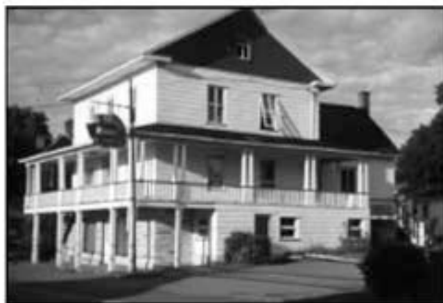
Le commerce avant sa démolition, en 1985
