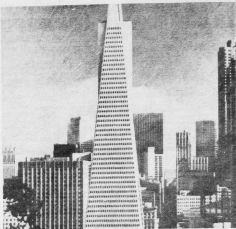
SYMBOLE — Quand cette tour fut construite en 1972, la majorité des gens de San Francisco la décrièrent. Ils déchantent maintenant puisque cette tour est devenue le symbole de la ville, des milliers de touristes la visitant chaque année. (Téléphoto PA)
