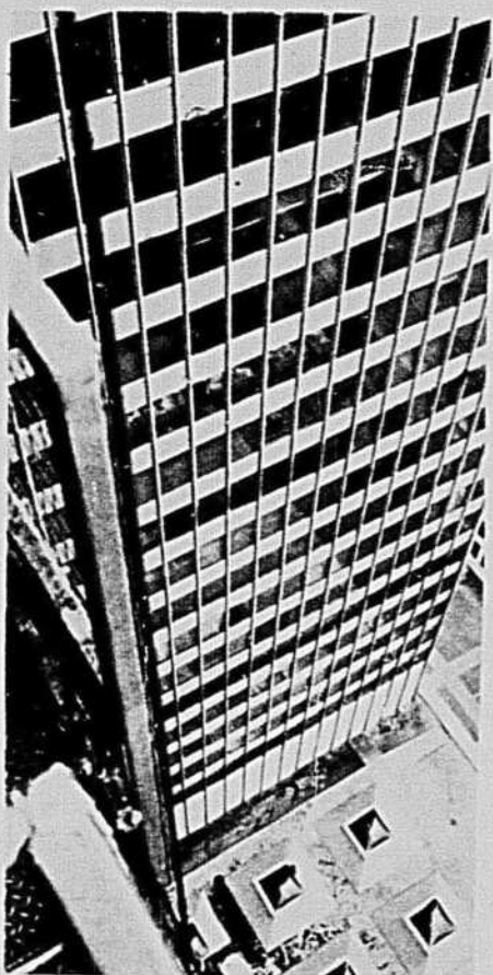
Nous sommes sur la plate-forme, à peu près à mi-chemin entre le sol et le toit de l'édifice.
