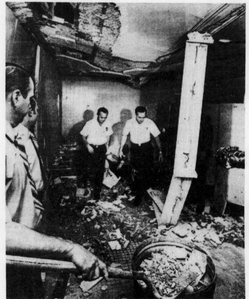
Une explosion d'une très grande violence a ébranlé vendredi un immeuble fédéral de Los Angeles. Un jeune gardien de 18 ans a été tué à proximité d'une bombe placée dans un panier à ordures. La plupart des 6.000 employés travaillant dans cet immeuble ont dû être évacués. C'est la troisième fois en un mois qu'un immeuble public est touché par une explosion à Los Angeles; les 1er et 13 janvier, une cour municipale et l'immeuble de la Chambre de Commerce étaient la cible de dynamiteurs que l'on n'a pas encore capturés. (Téléphoto AP)
