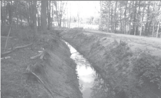
Figure 10. Ruisseau partiellement aménagé
