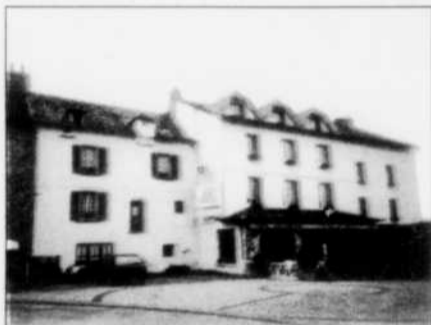
L'AUBERGE Loustal del Barry, haut lieu de l'accueil et de la restauration à Najac.
