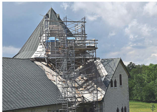
Déjà amorcés, les travaux sont estimés à 20 millions de dollars. (Photo Le Reflet du Lac - Dany Jacques)
