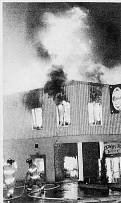
Le feu a largement endommagé la vieille partie de la fromagerie.
