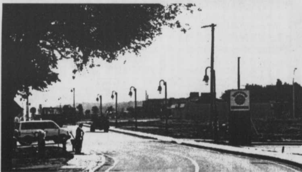
La Montée-Masson, à Mascouche, a fière allure avec ses magnifiques trottoirs et ses superbes réverbères. Les travaux de réfection vont bon train. Dans quelques mois, nous pourrons y circuler allègrement et... en douceur! (Texte et photo: André Côté)
