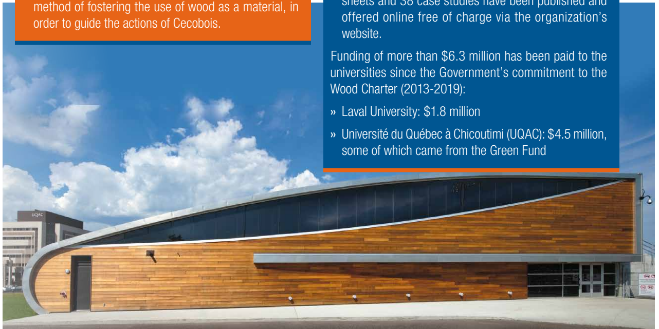
Hockey stadium and service building, Université du Québec à Chicoutimi Photo: Cecobois
