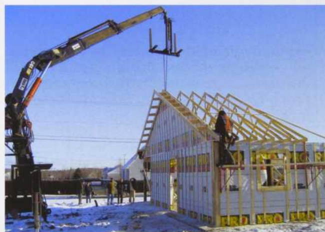
Assemblage de composantes préfabriquées de systèmes de construction en bois.
