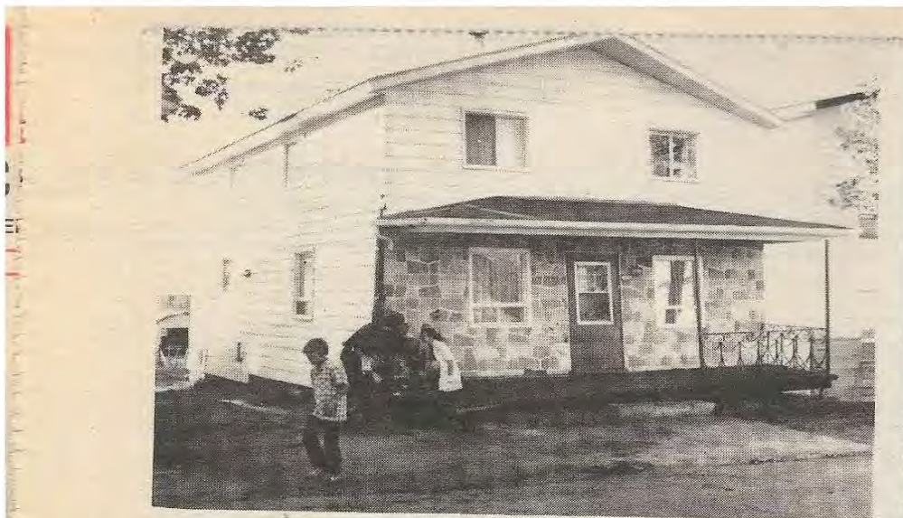
La résidence de Mme Jeannette Brochu, sise au 4303 rue principale, a subi d'importants dégâts. Si les dommages à l'extérieur ne semblent pas désastreux au premier coup d'oeil, il faut dire que la maison a reculé sur son seuil d'environ 25 centimètres. L'état de l'intérieur est beaucoup plus éloquent sur la violence de l'impact. [P.B. Peuple-Courrier]
